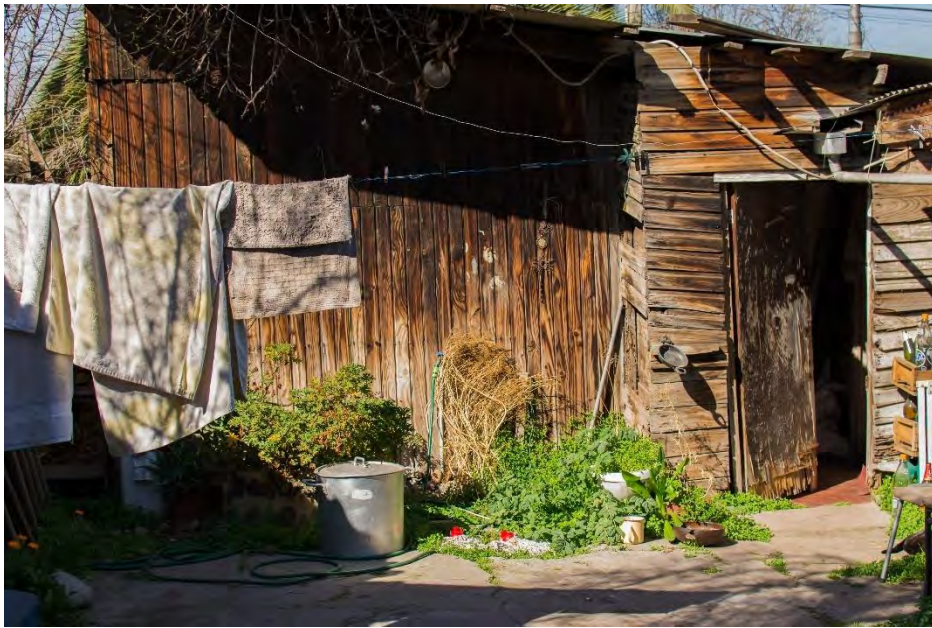
Fig.29. Ampliación en Caseta Sanitaria, La Pintana.
