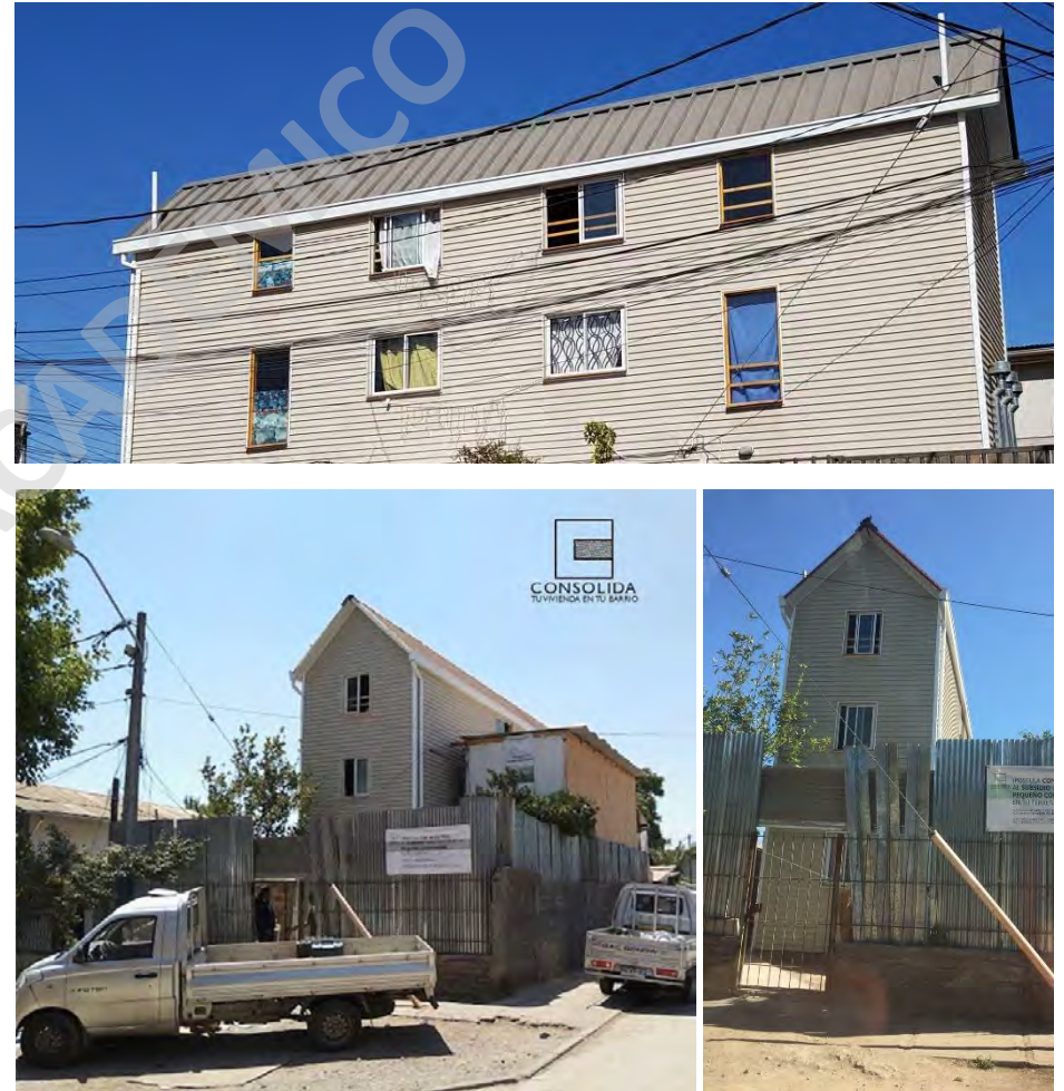
Fig.5. Pequeños Condominios, Construidos, Población La Faena.
