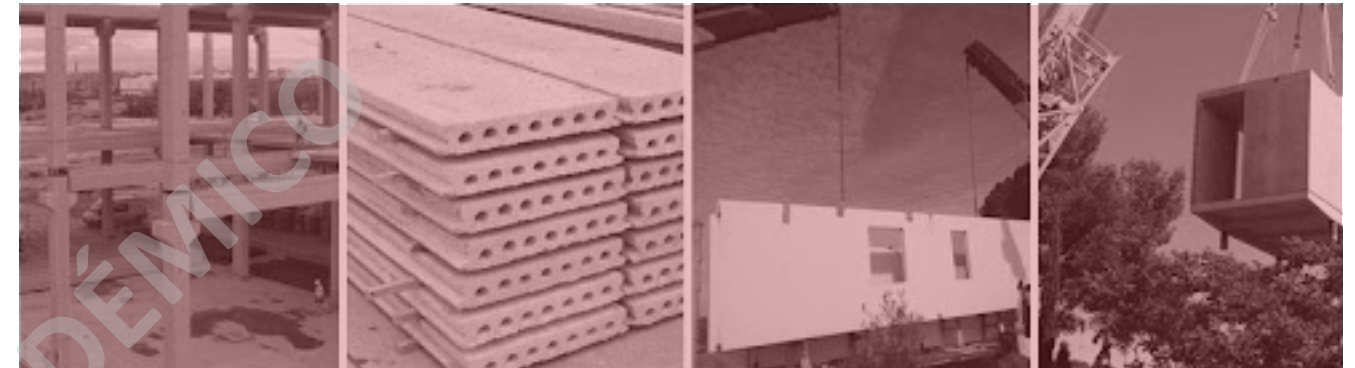
Figura 17. De izquierda a derecha se ve el orden de clasificación por prefabricación: Materiales, Elemento, Paneles, Módulo. (Fuente: Elaboración propia a base de imágenes de empresas de prefabricación)
