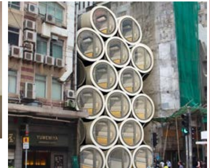
Figura 28. Imágenes de la Tipología OPOD, construcción en tuberías de hormigón.
