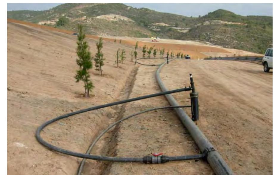
Figura 69: Israel Alba Ramis, Arquitecto (2015). instalación de colectores superficiales de recogida de biogás, 2009 [AMB].
