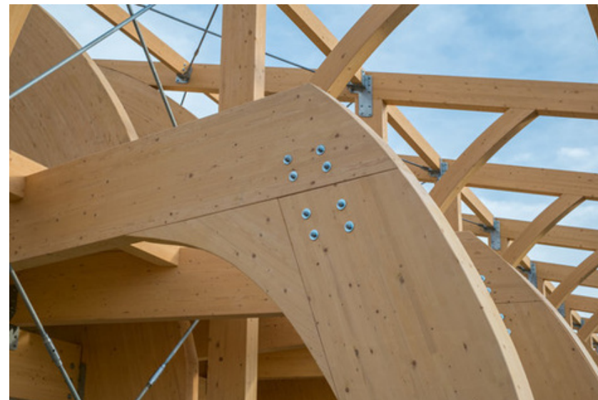
tipo de uniones mediante ensamble y herrajería metálica.
