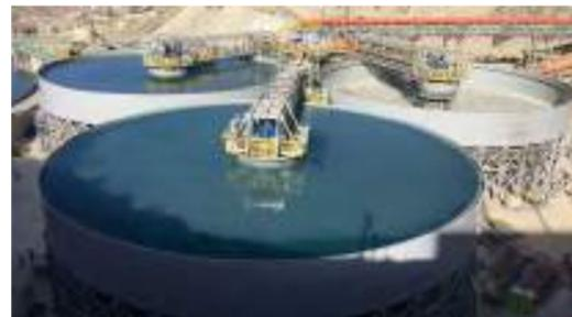
Figura 22. Espesador de Relave prefabricado. Fuente:
