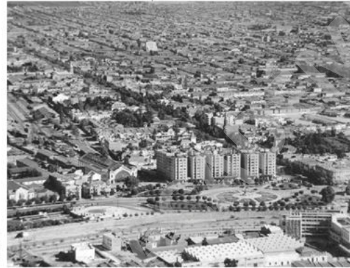
Vista hacia Plaza Baquedano
