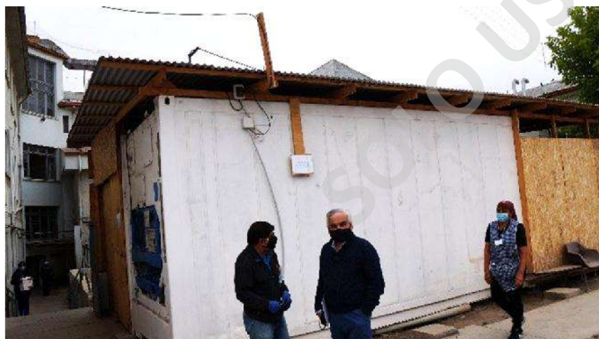
Obstrucción para accesos. (container en donde se albergan difuntos)
