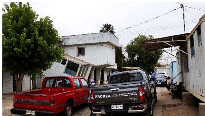
Perjudicando el paso, junto a ciertos containers, se usa el camino como estacionamiento y tira de residuos.
