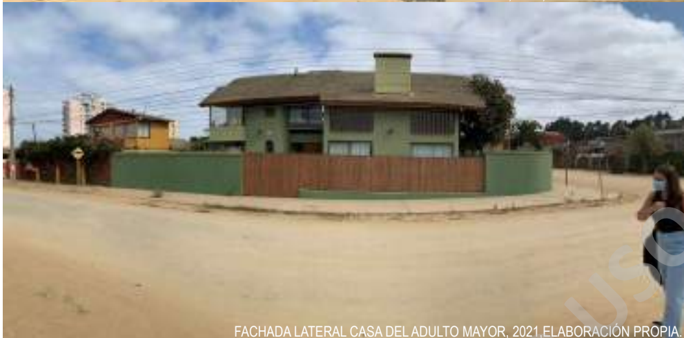
FACHADA LATERAL CASA DEL ADULTO MAYOR, 2021, ELABORACIÓN PROPIA.
