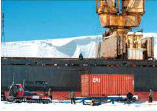
Fig 05.01 Los módulos vienen en contenedores los cuales luego son trasladados hacia el lugar de construcción . Fuente <http://www.antarcticstation.org/station/construction>
