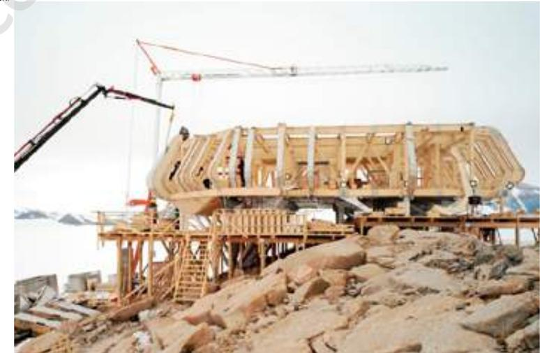
Fig 05.05 Montaje de las pletinas apernadas en donde luego se posarán las vigas de piso para poder conformar la estructura de suelo. Fuente: [http://www.polarfoundation.org/assets/uploads/presspictures\\_images/princess\\_elisabeth\\_antarctica\\_5years-3.jpg](http://www.polarfoundation.org/assets/uploads/presspictures_images/princess_elisabeth_antarctica_5years-3.jpg)
