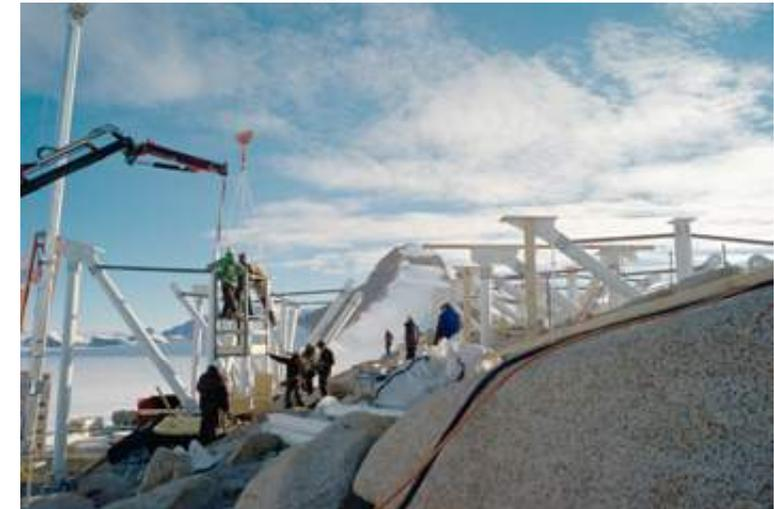
Fig 05.04 Montaje de los arcos para así formar la estructura perimetral que protege de los vientos. Fuente: <https://polarjournal.ch/en/2022/05/30/princess-elisabeth-antarctica-zero-emission-polar-research/>
