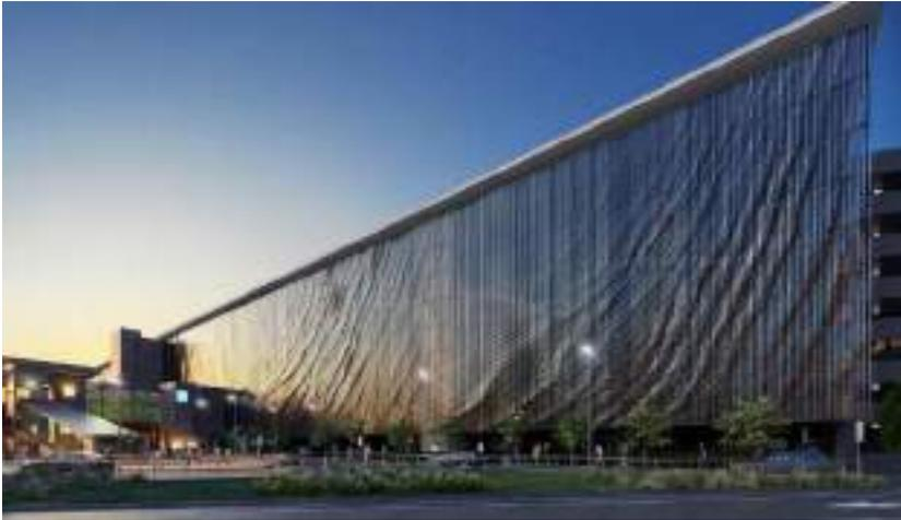
Fig. 49 | Fachada cinética se mueve con el viento en el estacionamiento del aeropuerto de Australia
