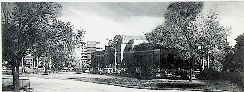
A modo de ejemplo, en la fotografía un sector de Vitacura factible para la construcción de estacionamientos subterráneos.
