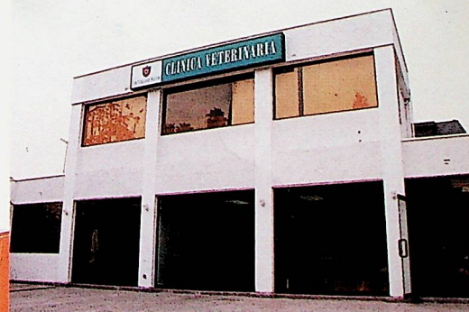
En un inmueble de dos pisos, ubicado en Avda Ossa 1139, funciona la primera Clínica Veterinaria de la Universidad Mayor.
