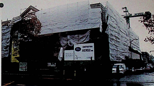
En su fase final se encuentran las obras de construcción de la Nueva Sede Alameda, donde se ubicarán las Carreras del Área de la Salud
