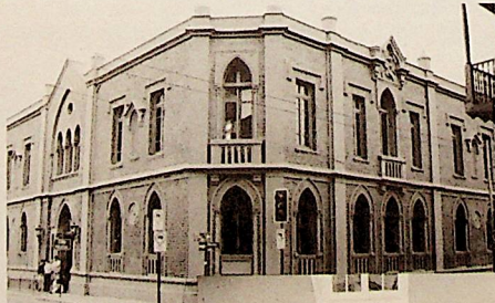
"El edificio, ubicado en Santo Domingo esquina de Mac Iver y que data de 1810, fue restaurado por la Universidad Mayor".
