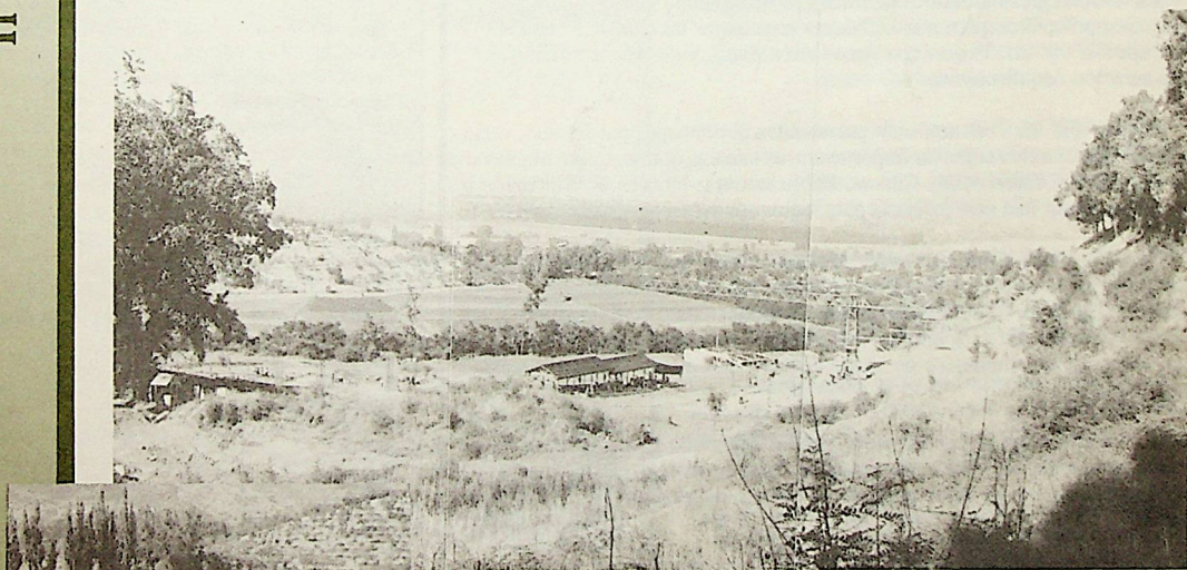
«Panorámica del Terreno de 5 hectáreas, que ubicado en el sector de La Pirámide, Comuna de Huechuraba, se construye el nuevo Campus de la Universidad Mayor».
