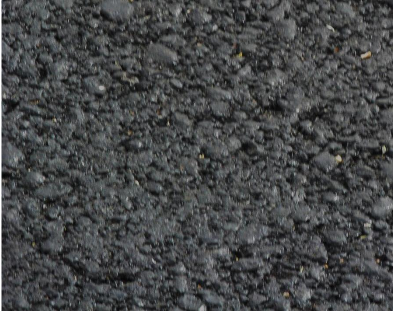
Concreto rodadura: Lisa
