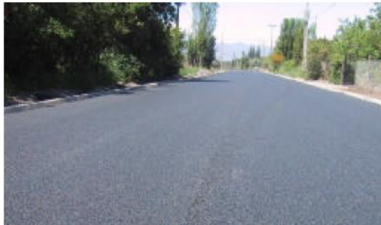
Tramo experimental Ruta E-85, Los Andes, 2002.
