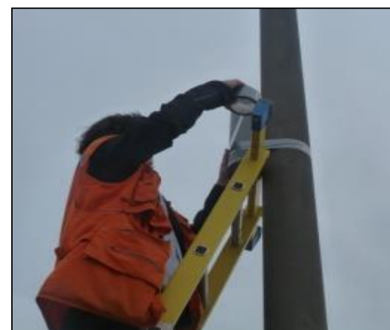
Fijación equipo de medición en poste de iluminación. (Fuente: Análisis de Impacto acústico, Servicios de acústica ambiental)
