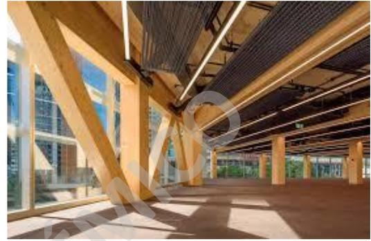
Fig. 30 (Pilares – Vigas Laminadas )
