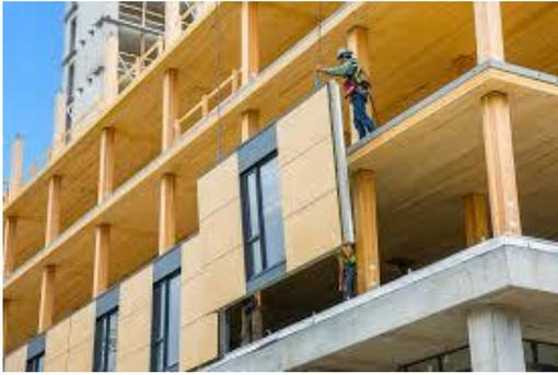
Fig. 29 ( Montaje Paneles CLT )
