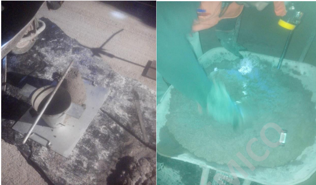
Figura 38, toma de cono y temperatura del hormigón antes de empezar la descarga directa en la máquina. Septiembre 2015.
