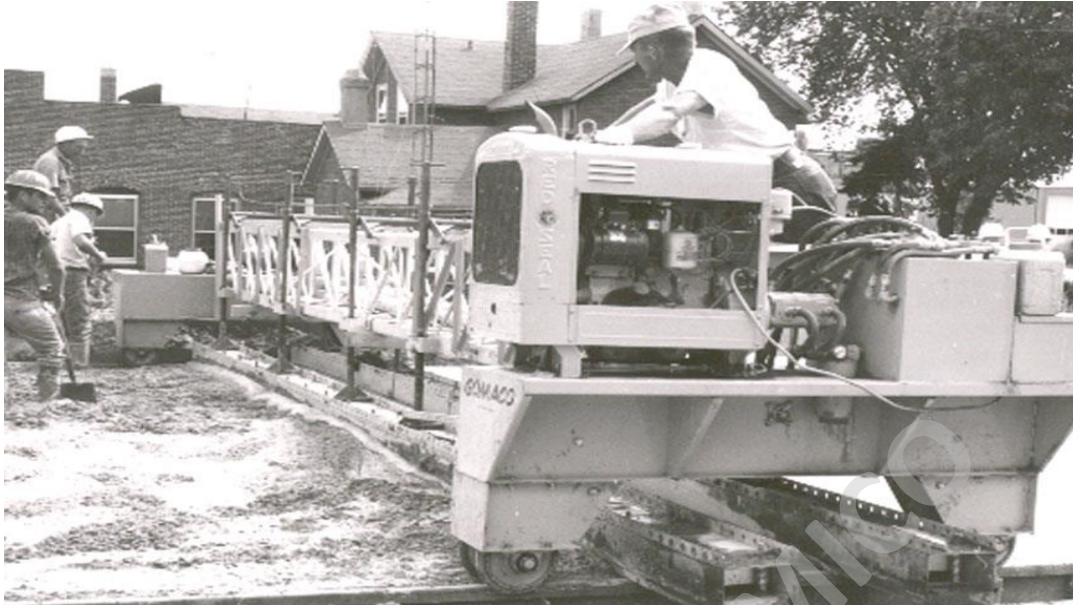
Fotografía 1. Equipo Doble oscilante como acabadora de cubierta screed. Fuente GOMACO
