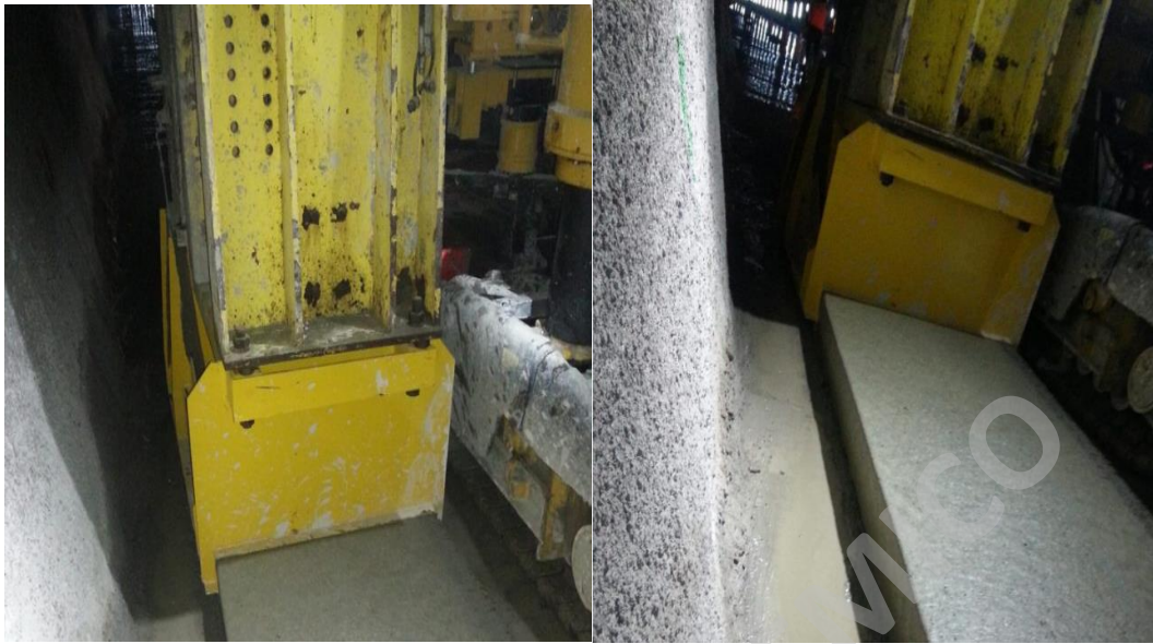
Fotografía 48, moldaje para construir los sobre losa de ,15 metro ó 15 cm. (www.soleras.cl, 2017)
