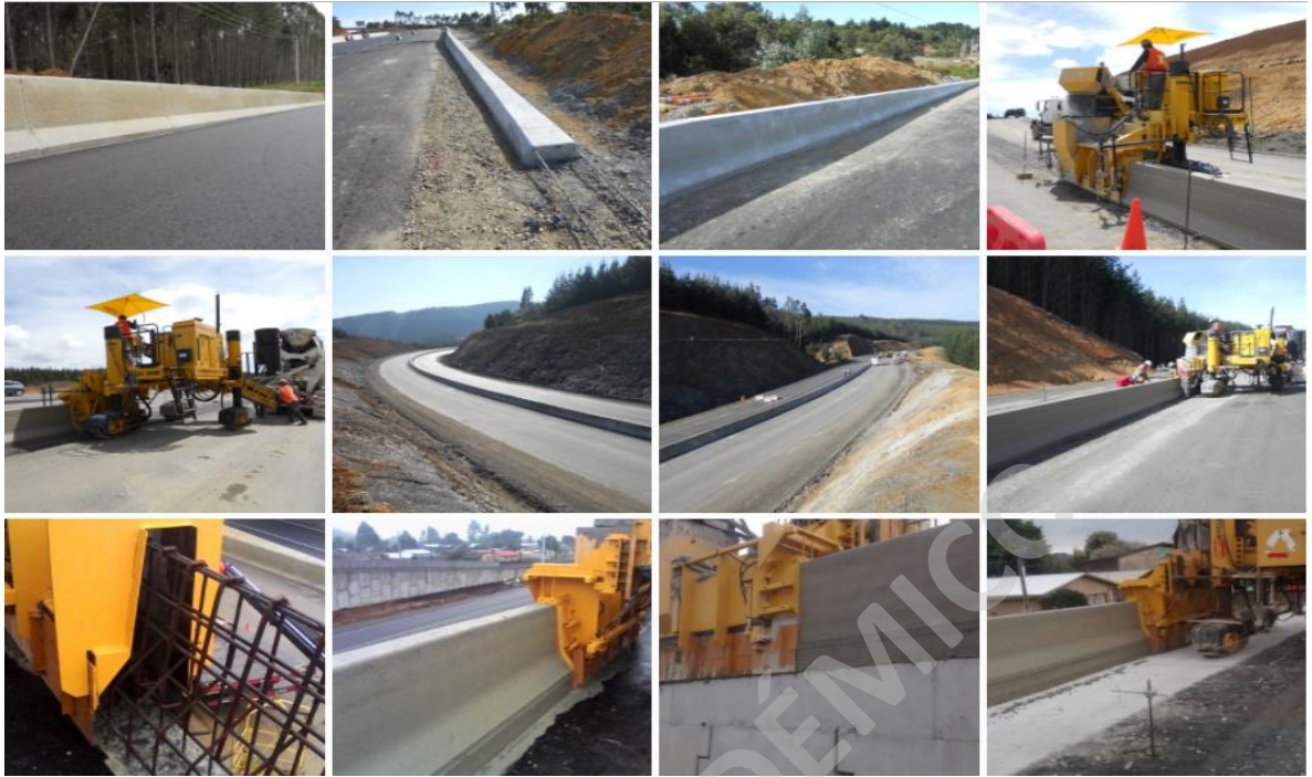
Fotografía 14. Barrera; Parapeto; Cuneta; Solera Tipo A con zarpa, proyecto RUTA 160, empresa ejecutora HORMITEC. (HORMITEC-R160, 2017).
