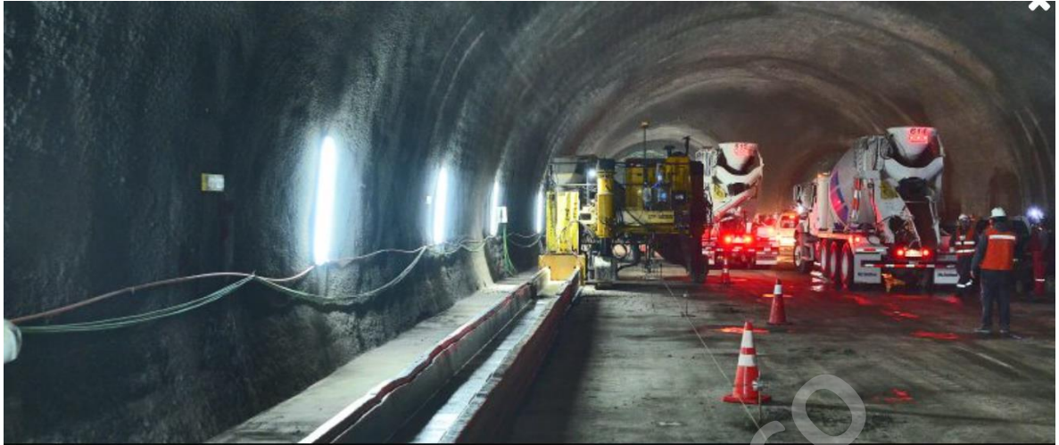
Figura 40, construcción de la canaleta y descarga de camiones MIXER, line3 ENLACE, Julio 2016 (ready mix, 2017)
