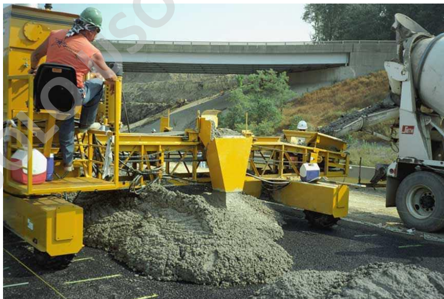
Fotografía 3. Distribuidor horizontal de hormigón. (GOMACO)
