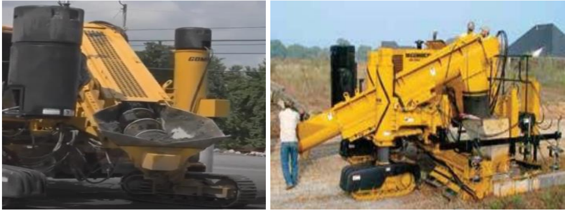
Fotografía 18. Sistema de Barrena o tonillo sin fin, para mantener el hormigón en movimiento
