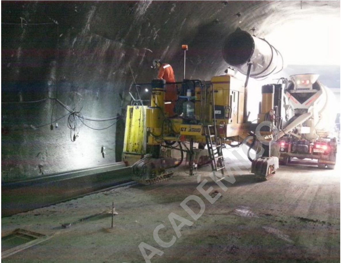
Fotografía 44 , otra zona de trabajo cerca de estación FRANKLIN. (www.soleras.cl, 2017)
