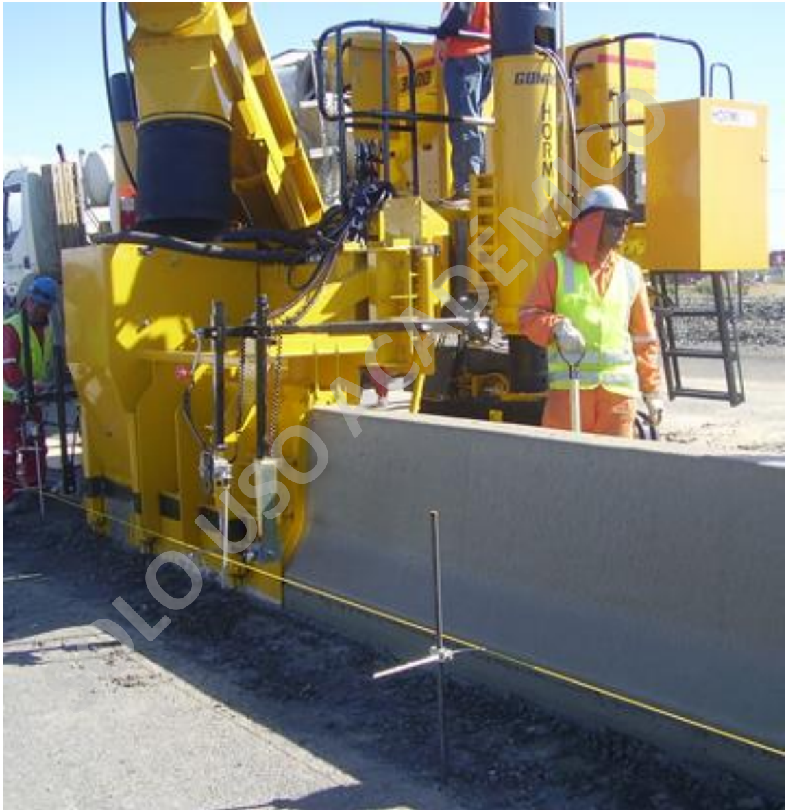
Fotografía 6. Recortadora/Pavimentadora de Encofrado.
