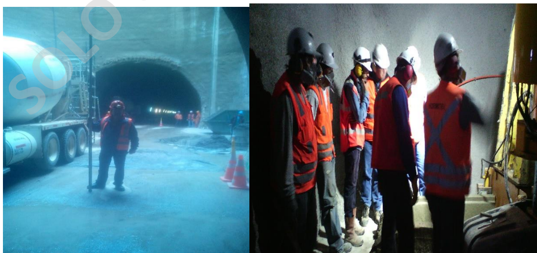
Fotografía 27. Personal de trabajo equipado para la obra diaria.
