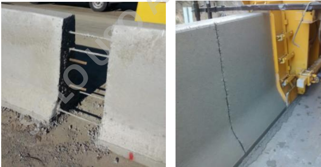
Fotografías 9 y 10. Detalles constructivos del hormigonado de defensas camineras.
