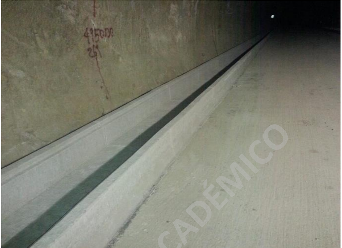
Fotografía 49, después de semanas de fraguado, se produce la terminación de la canaleta. ( www.soleras.cl , 2017)
