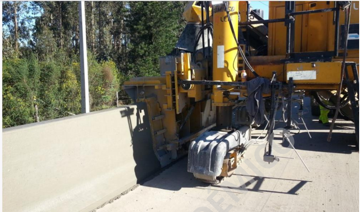
Fotografía 8. Hormigonado de Barrera de seguridad Cerro la Pólvara.
