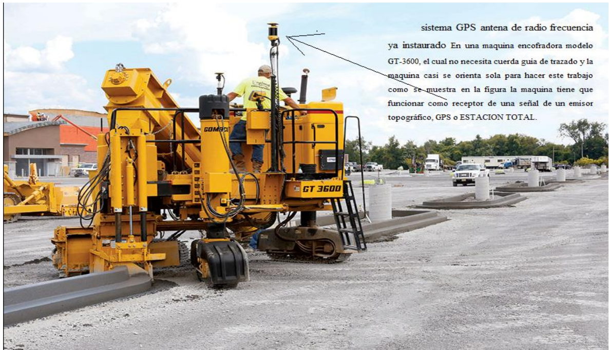
Fotografía 23. Encofradora de hormigón GT-3600, ya con el de radio frecuencia 3D
