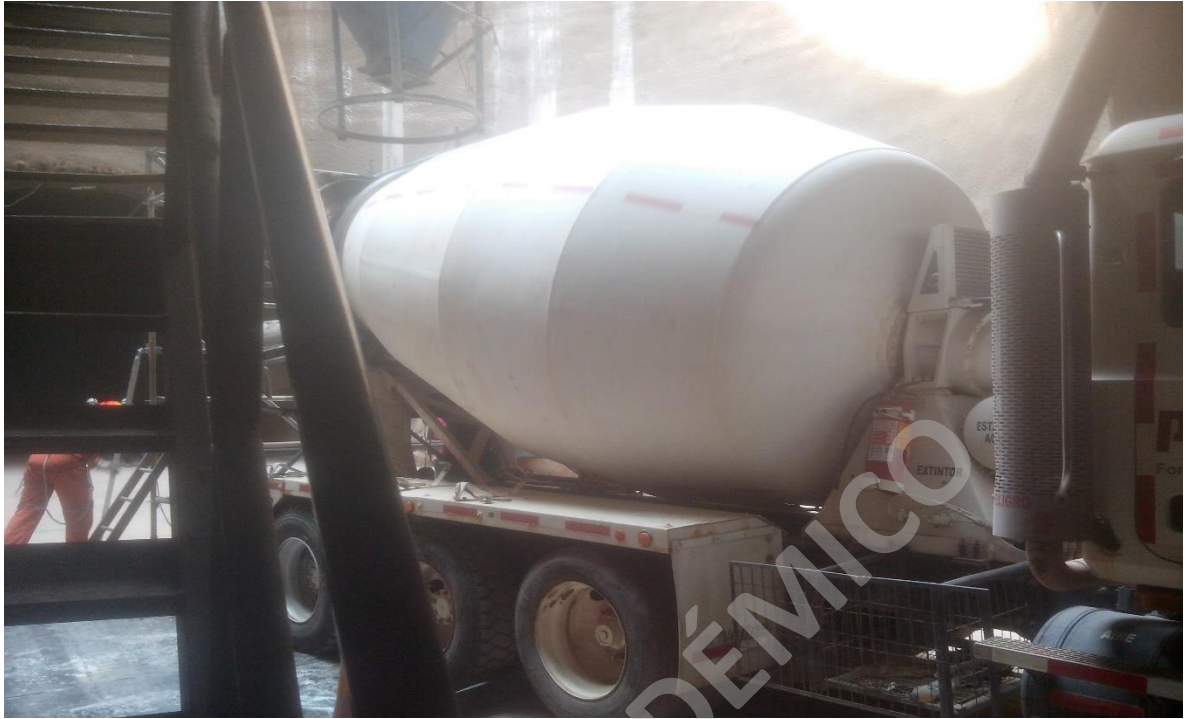
Fotografía 33, descarga con capacho con dos personas autorizadas
