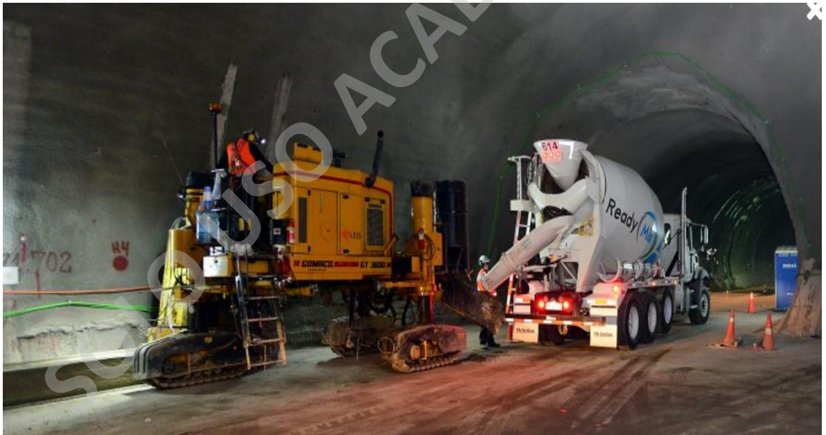
Figura 39, fotografía ilustrativa de descarga en otra máquina GOMACO gt-3600, línea 3 ENLACE. JULIO 2016. (ready mix, 2017)
