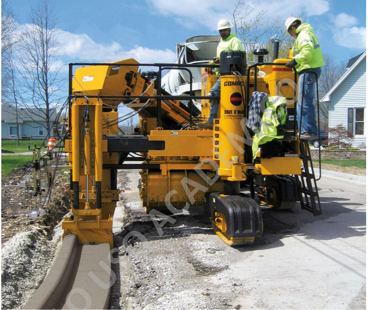
Fotografía 4. Pavimentadora de encofrado deslizante GOMACO GT-3600. (GOMACO, 2017)
