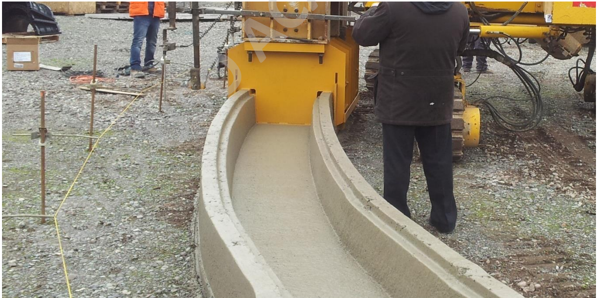
Fotografía 29 , primera prueba en dependencias de Leis con hormigón Polpaico (polpaico, 2017)
