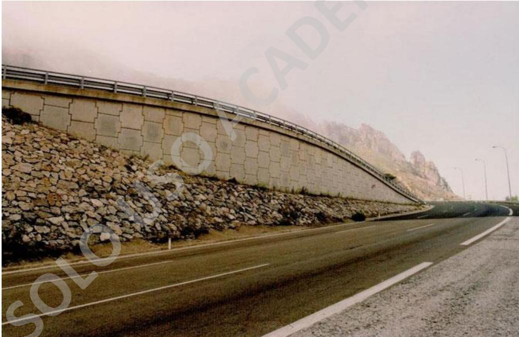
Figura N°7: Paramentos de Muro y Tierra Armada. (Fuente: [http://www.tierra-armada.com/tae/index.php?option=com\\_content&view=article&id=4&Itemid=11&lang=es](http://www.tierra-armada.com/tae/index.php?option=com_content&view=article&id=4&Itemid=11&lang=es))
