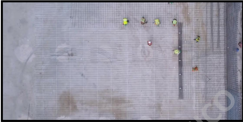
Figura 26, Enfierradura de losa, Fuente: ATCacero
