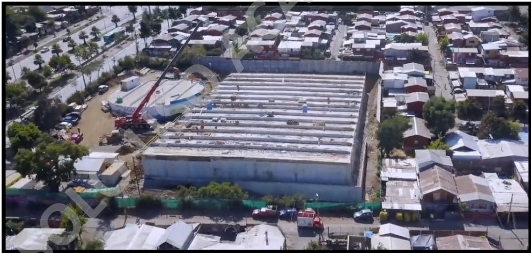
Figura 27, Vista aérea de estanque Aguas Andinas, Fuente: ATCacero
