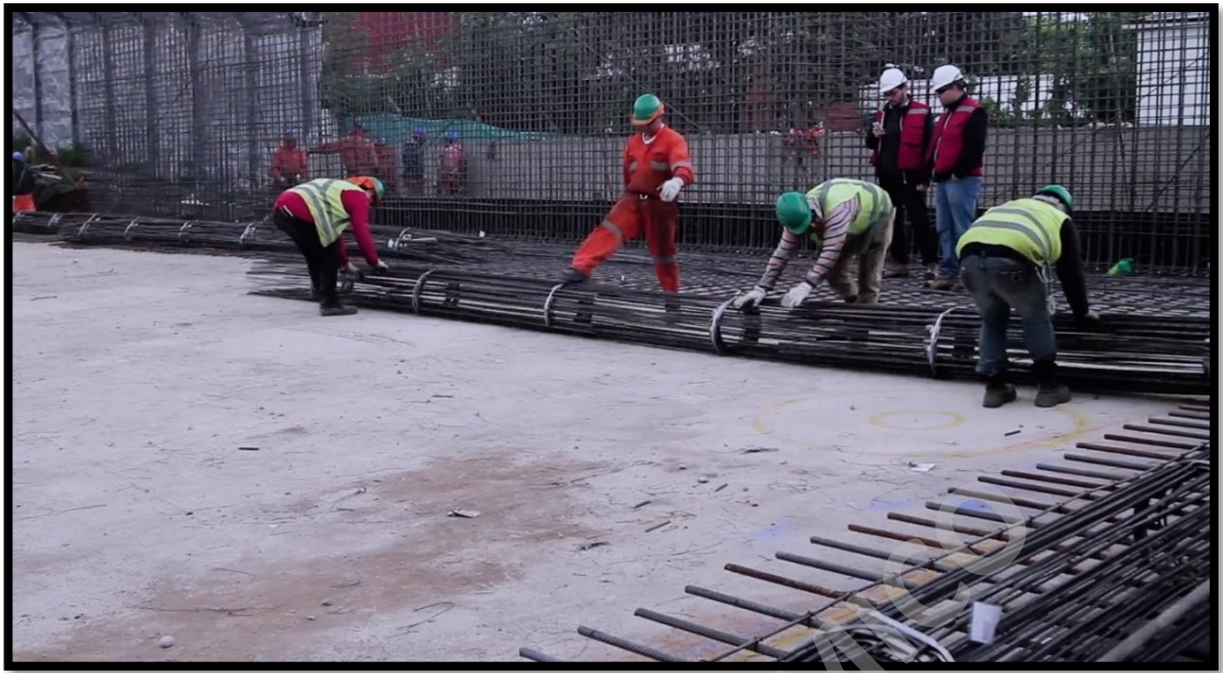
Figura 28, Colocación de rollos, Fuente: ATCacero
