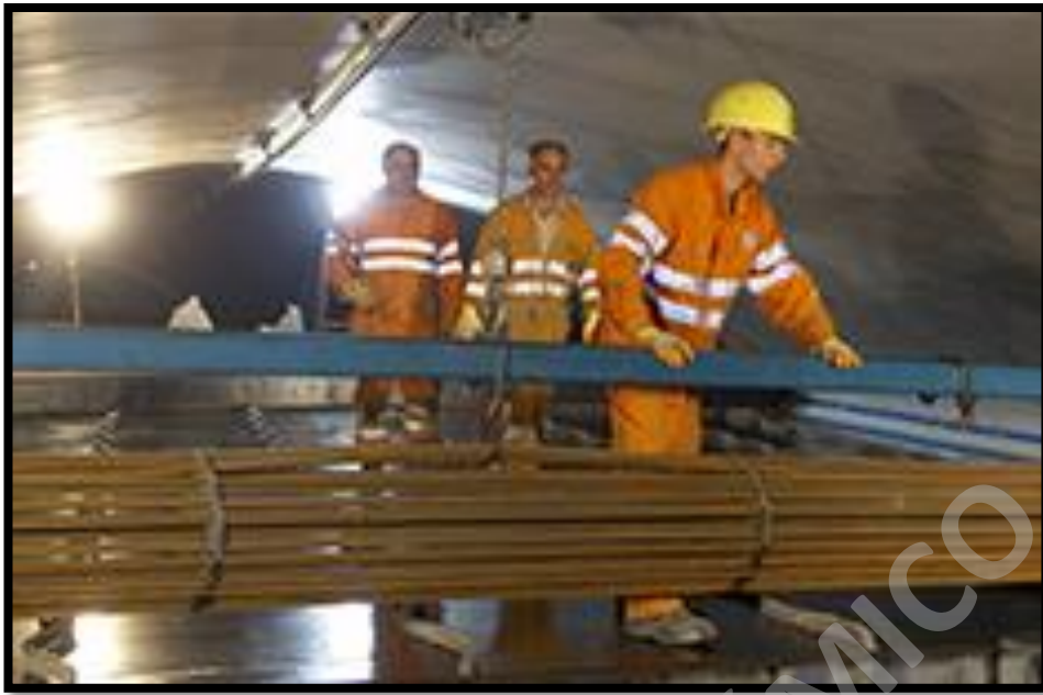
Figura 21, Estación metro Estadio Nacional e Inés de Suarez, Fuente: Google
