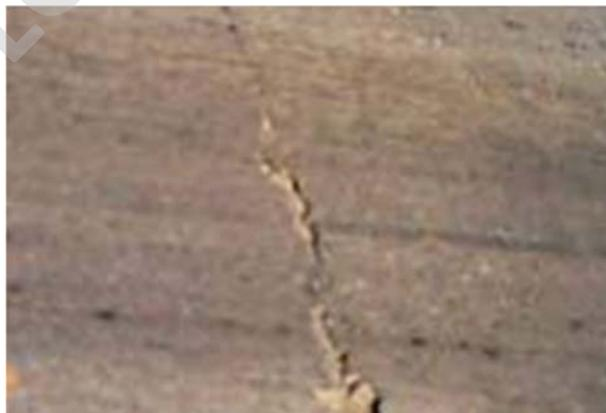
*Fotografía 14 Grieta dañada por desgaste.
