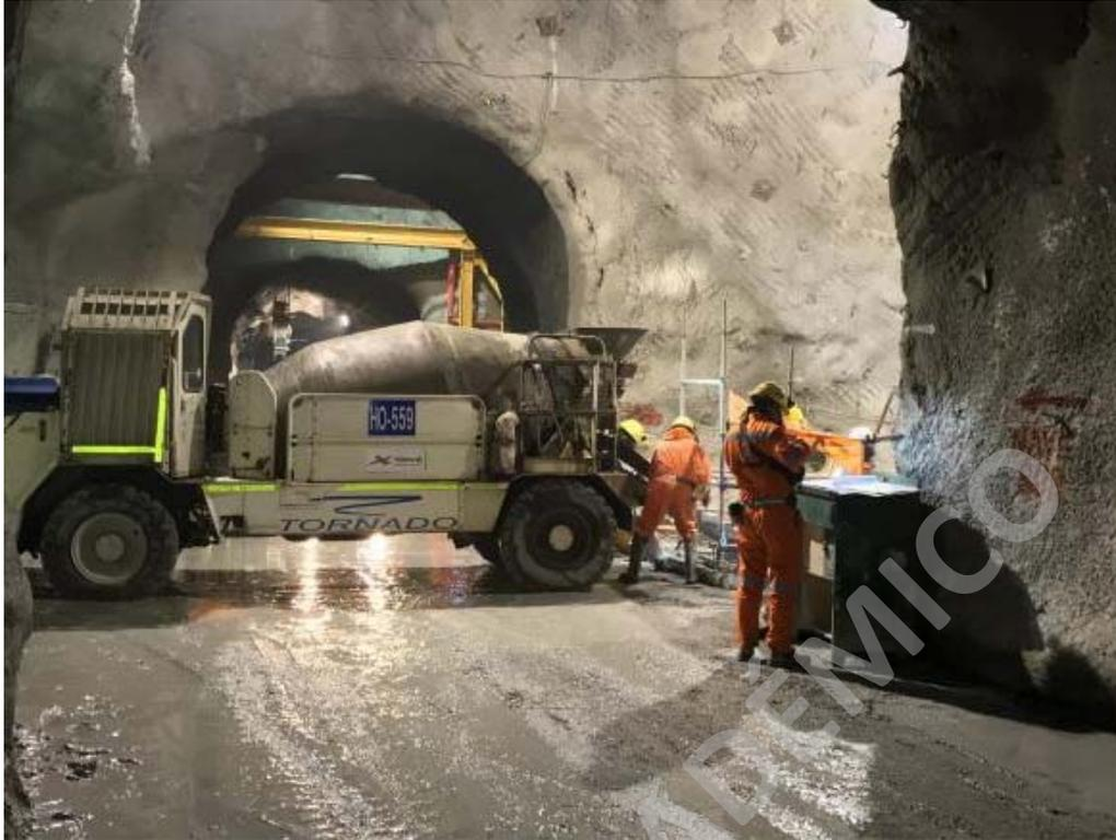
*Fotografía 6 Proceso de descarga del hormigón en la faena
