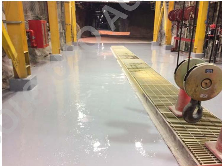
*Fotografía 4 Mantenimiento de pisos según especificaciones, imágenes de la Vista a la Sala eléctrica. Fuente: BMX-235, áreas Ingeniería de empresa Bormax*
