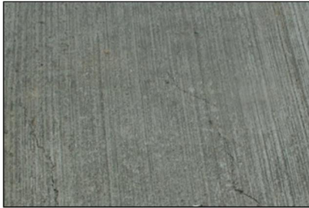
*Fotografía 9 Grietas por retracción plásticas generadas por viento.
