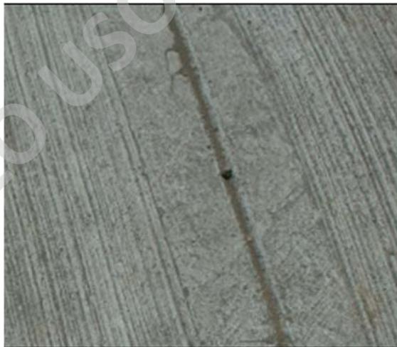
*Fotografía 11 Grieta en borde de la junta de dilatación.
