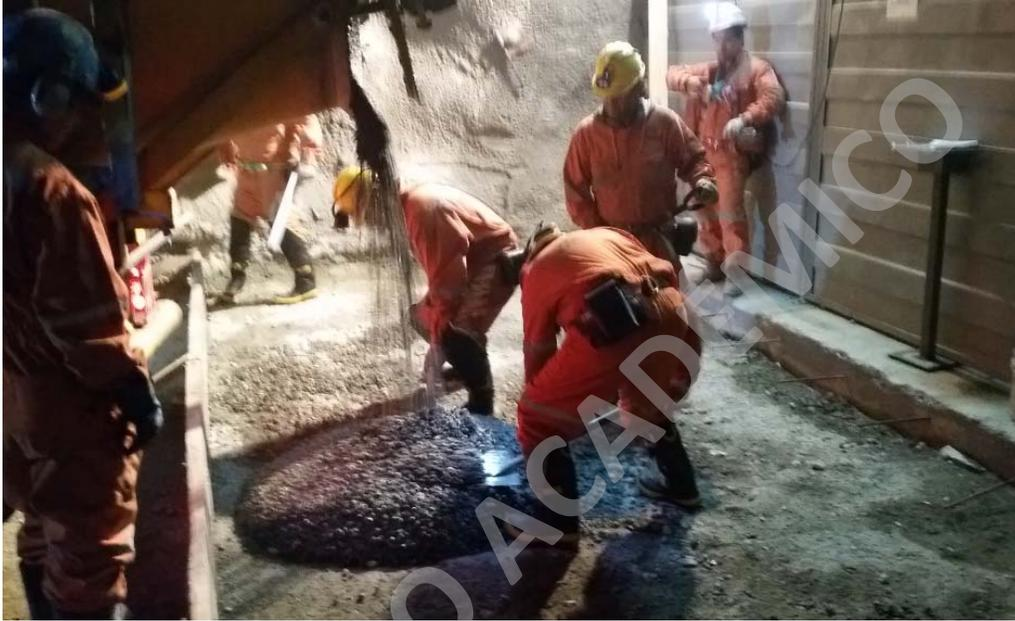
*Fotografía 5 Imagen de vaciado del Hormigón en faena. Fuente: BMX-235 Área de Ingeniería Bormax.*
