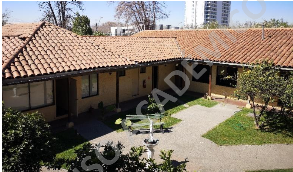
Imagen N° 63: Cubierta de techumbre existente.
