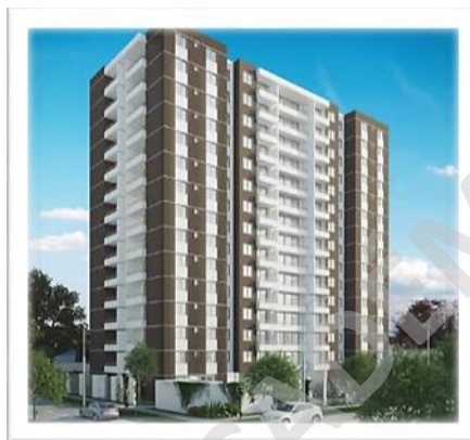
Figura 12 Edificio Manuel Montt
