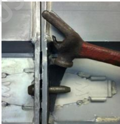
Imagen N° 26. Cuña de apriete en cada extremo de las corbatas con martillo especial.
