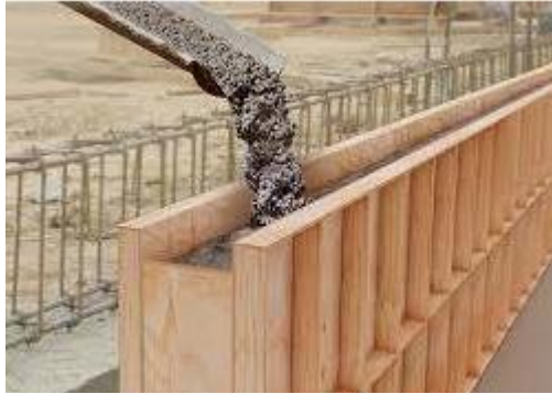
Imagen N °9. Moldaje de madera Selex.
