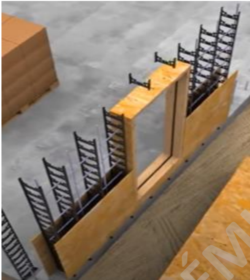
Imagen N° 15. Construcción de los vanos de ventanas en el desarrollo de muros, con el sistema Spider Tie.
