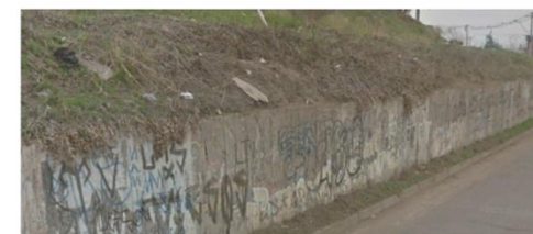
PERÍMETRO CON ALTURA DE ENTRE 1 Y 1,5 METROS
