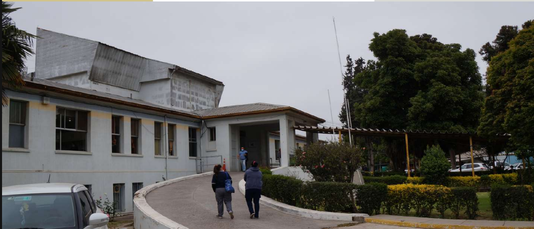
ACCESO ACTUAL DEL HOSPITAL SAN MARTÍN. ELAV. PROPIA
