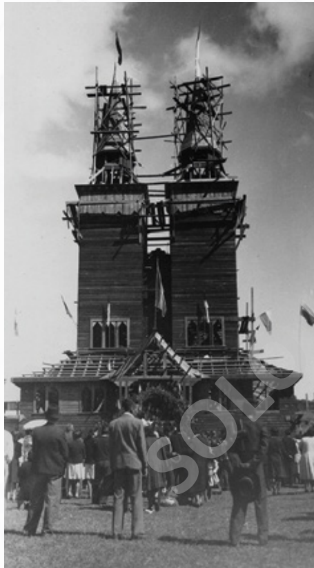
Construcción Parroquia San Sebastián, Panguipulli.
