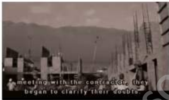
Figura 30: | Quinta Moroy en proceso de construcción. Fuente: (Chile Barrio, 2006)
