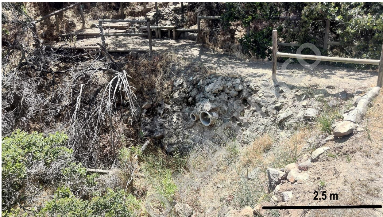
Figura 4.24: Contención aluvial occidental en cuchilla norte de la zona aluvial baja.
